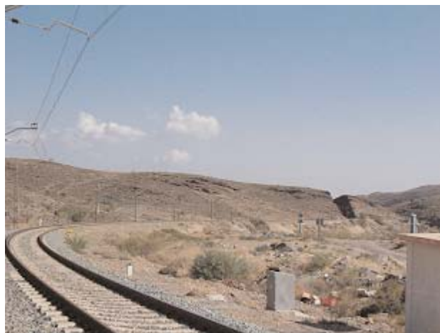
La entrada a la trinchera Zamora, pudiéndose apreciar la electrificación de 1987
