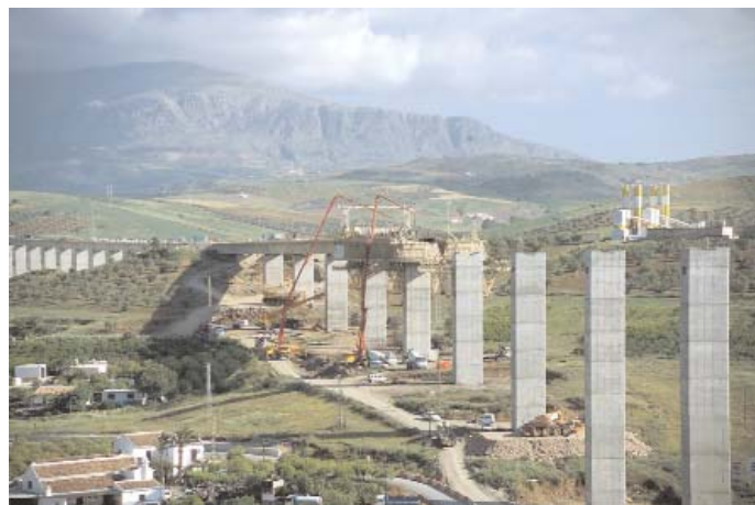
Puente en construcción en la línea de Alta Velocidad de Córdoba a Málaga. Foto Fundación de los Ferrocarriles Españoles
