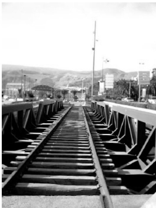
La conexión ferroviaria con el puerto de Almería tiene dispuesta su infraestructura para hacer efectiva la relación puerto-ciudad. ARCHIVO ASAFAL.
