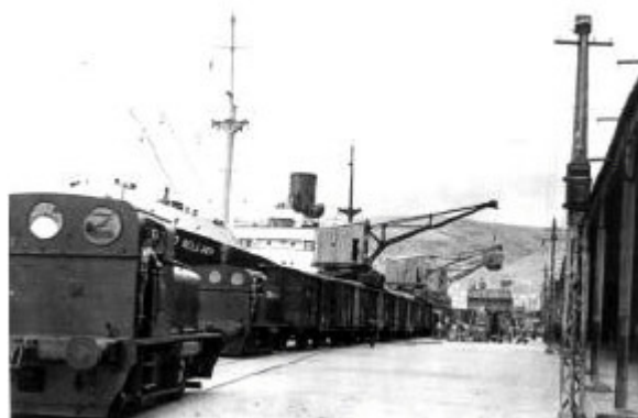
Actividad ferroviaria en el puerto de Almería en 1950. ARCHIVO ASAFAL.
