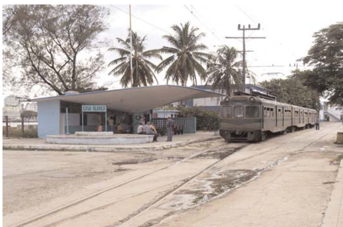
Estación de Casablanca del ferrocarril eléctrico de Hershey
