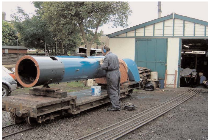
Ilustración 2. Trabajos de mantenimiento y rotonda para locomotoras del ferrocarril Romney, Hythe & Dymchurch. Fotografía: Gerald Strowbridge.
